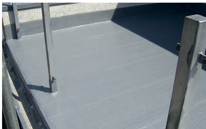
• Izdignutih građevinskih elemenata
