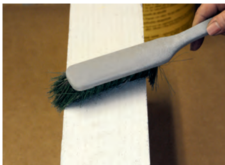
1. Podlogu očistiti
