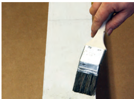
2. Nanos Univerzalnog predpremaza 933 kod odvajajućih podloga
