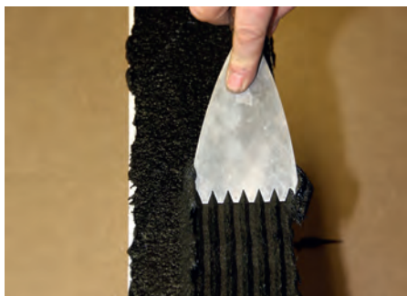
4. Posle lepka Enkolit® preći zupčastom lopaticom
