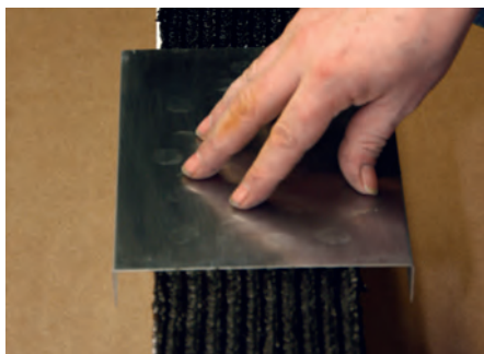
5. Podložni lim (prema potrebi) prilepiti
